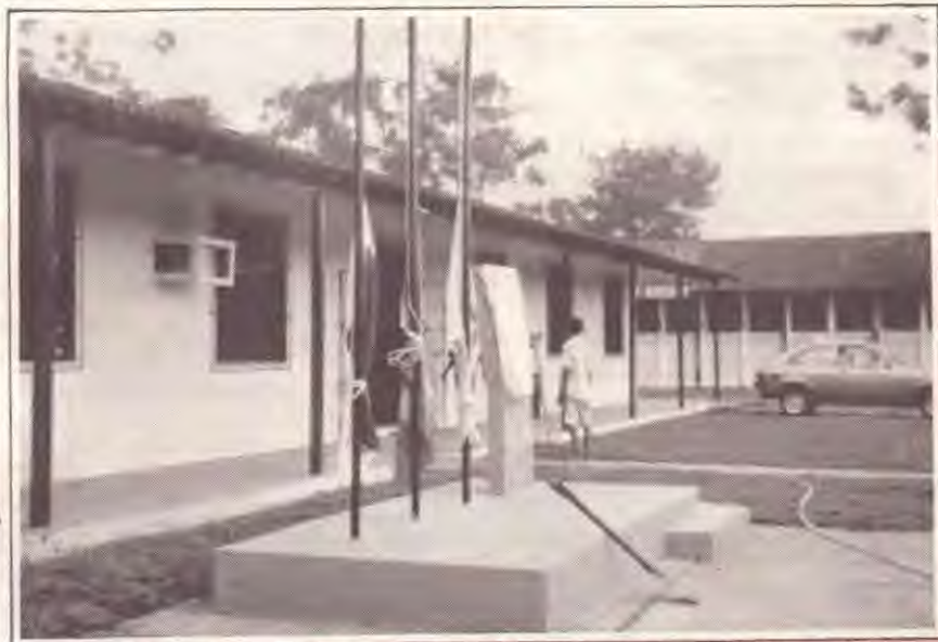
Vista parcial da Fachada do prédio do Juizado Especial na Cidade Nova.
